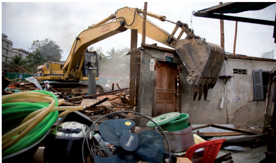
Bagger reißen bei einer Zwangsräumung in Phnom Penh alles nieder, Januar 2009 © www.nicolasaxelrod.com
